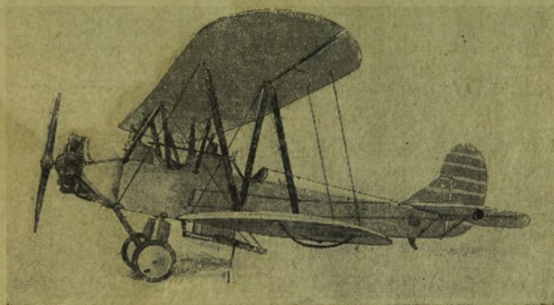
Рис. 4. Сельскохозяйственный самолет У-2 АП (аэроопылитель): 1—приспособление для распыливания
