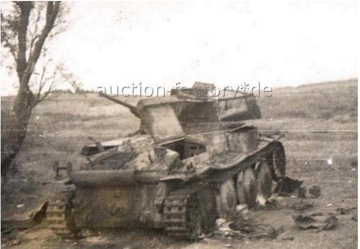
Сгоревшая «Прага». Ausf.V/C Танк отнесен к ранним исходя из «низкого» глушителя. На башне с трудом просматривается трехзначный номер. Танк сгорел, получив попадание в топливный бак. Боекомплект башни сдетонировал, танк сгорел полностью. Возможно, машину пытались потушить, отсюда – поднятые крышки МТО. Что интересно, противопожарные дверки БО/МТО уцелели, так что разорвавший башню взрыв БК никак не мог стать причиной поднятых крышек МТО.
